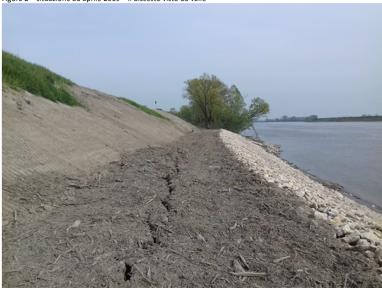
Figura 3 – situazione ad aprile 2019 – il dissesto visto da monte; in primo piano la fessurazione lungo la sommità del petto arginale
